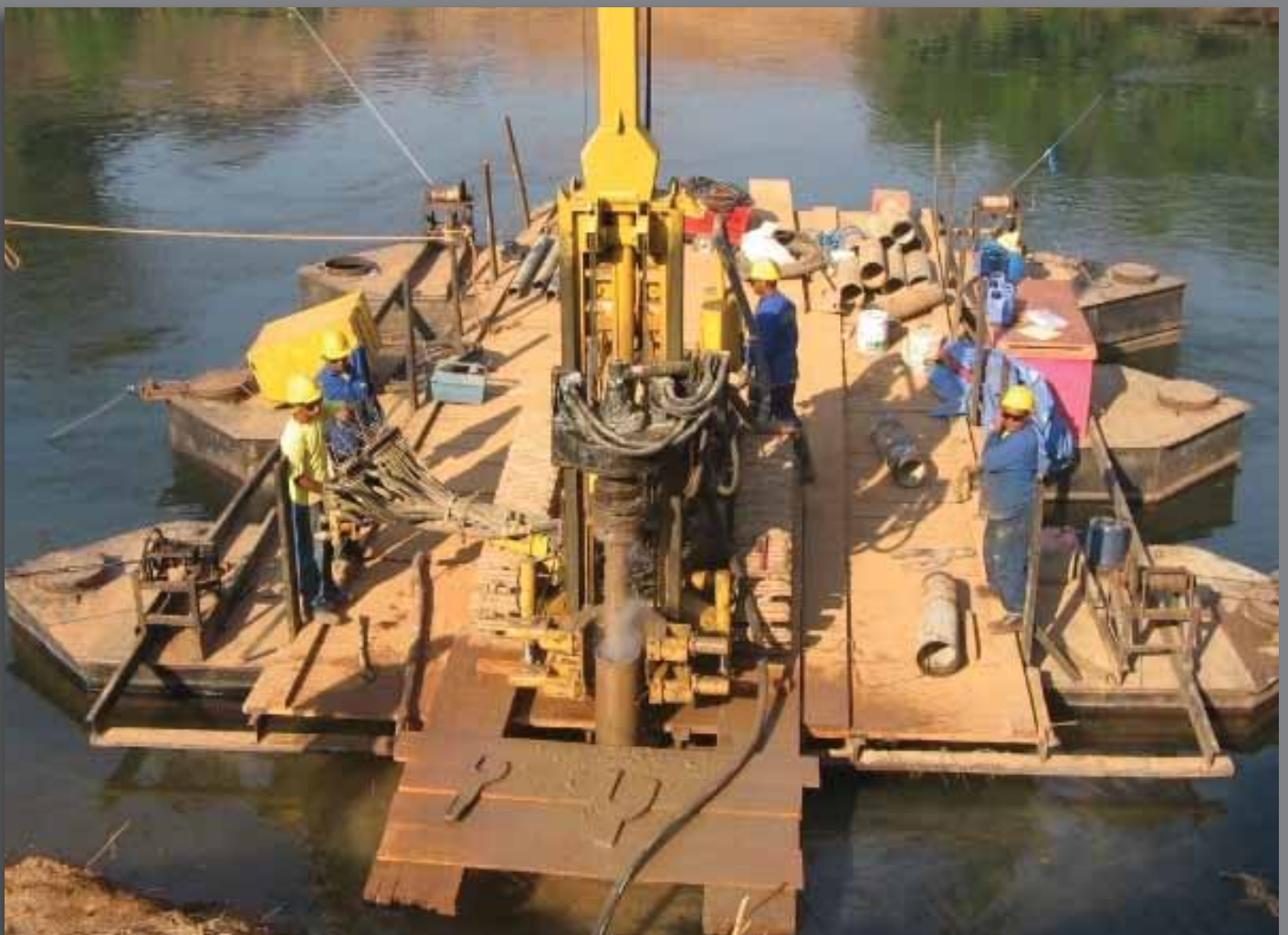
Trabalhando com martelo de fundo de furo - Working with down the hole hammer
