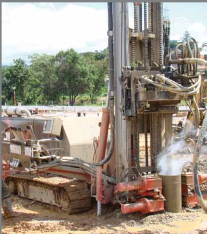
Trabalhando com martelo de fundo de furo - Working with down the hole hammer
